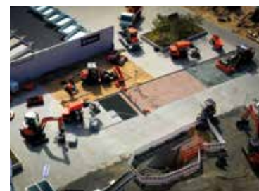
Site de construction d'échantillons Optimas Sud à Coreum, Stockstadt a. R.
